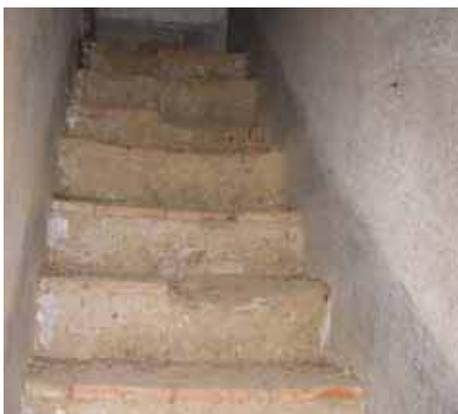
**Fig.52-53-54** Scala in terra cruda costituita da arco rampante in ladiri.
