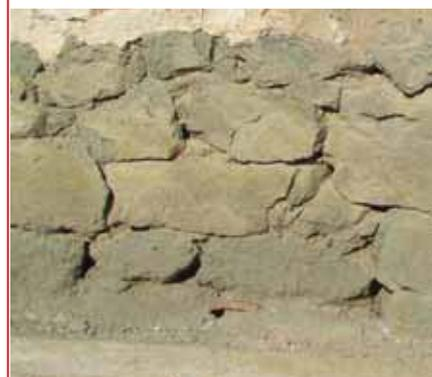
**BM 04** Basamento murario in conci sbozzati di arenaria con ricorsi orizzontali.
