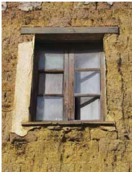
**Fig.27** Apertura realizzata con architrave ligneo poggiante su stipiti di mattoni cruda con l'alternanza di mattoni a tre quarti nei ricorsi successivi. Si noti ciò che rimane dell'incorniciatura in latte di calce dell'apertura. (foto di R. Spano)
