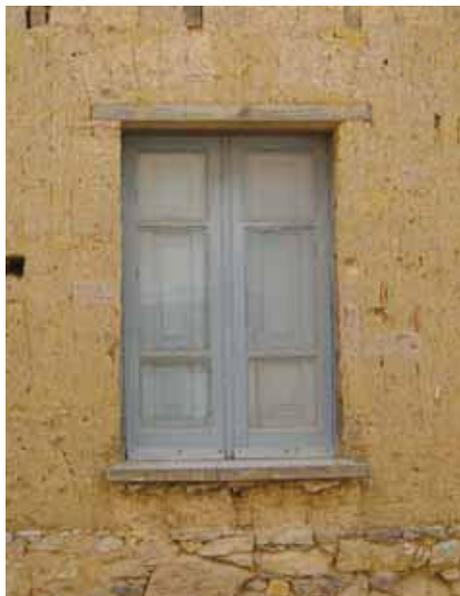
**Fig.31** Apertura di una casa a corte retrostante realizzata con architrave ligneo poggiante su stipiti di mattoni cruda con soprastante arco di scarico in terra cruda. (foto di R. Spano)
