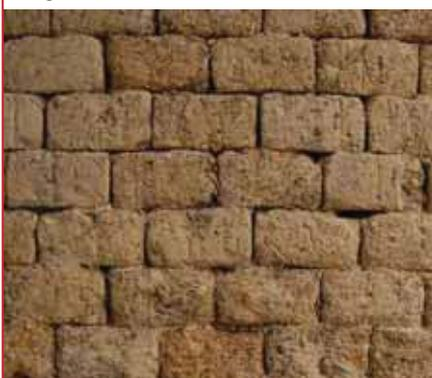
**M02** Muratura in blocchi pseudo-isodomi di andesiti (localmente denominata trachite di Serrenti) con ricorsi orizzontali e rinzeppature.
