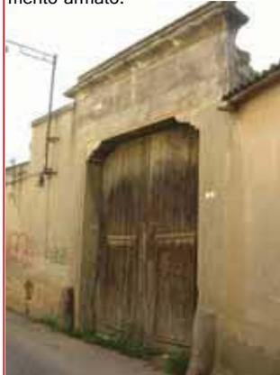
**P22** Ingresso pedonale alla corte con architrave ligneo (sostituzione con architrave in CA).
