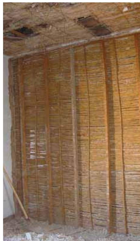
Fig.24 Partizione realizzata con ordito in travicelli e tamponamento costituito da incanniccio.
