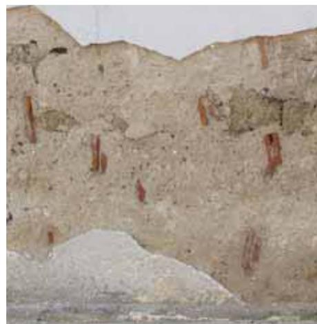
Fig.26 Intonaco tradizionale realizzato in malta a base di terra cruda
