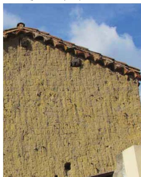
**Figg.46-47** Le due differenti soluzioni di testata costituite rispettivamente da un doppio filare di coppi convessi e da un aggetto ottenuto mediante una fila di coppi convessi annegati nel cordolo sommitale e un soprastante filare di coppi convessi. (foto di R. Spano)
