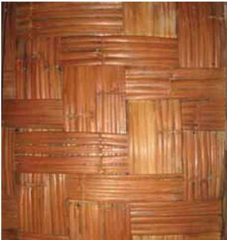
**Figg.37-38** Particolari dell'incanniccato e della stuoia di canne intrecciate detta *orriu*. (foto di R. Spano)
