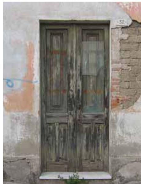
**Fig.32** Variante della soluzione S01, da ritenersi molto meno diffusa all’interno del centro storico, con architrave ligneo poggiante su stipiti realizzati in mattoni laterizi invece che in mattoni di terra cruda. (foto di B. Senis)
